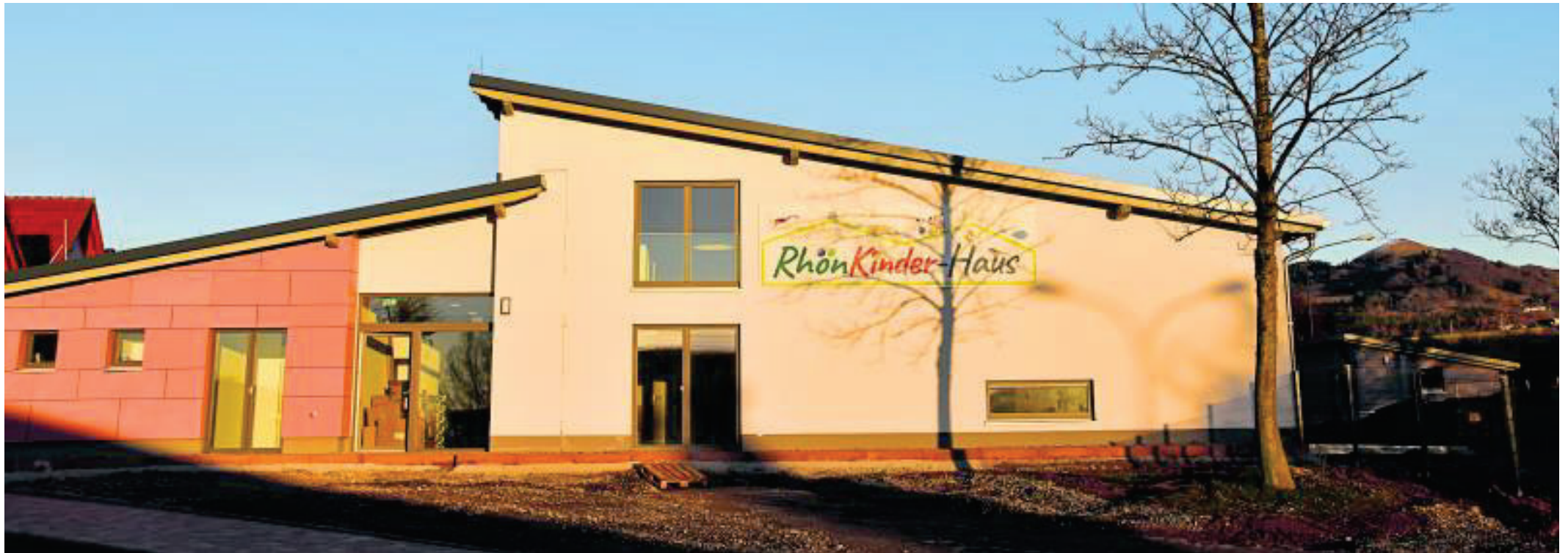
Der neue Kindergarten in Poppenhausen wurde in Massivholzbauweise errichtet.
